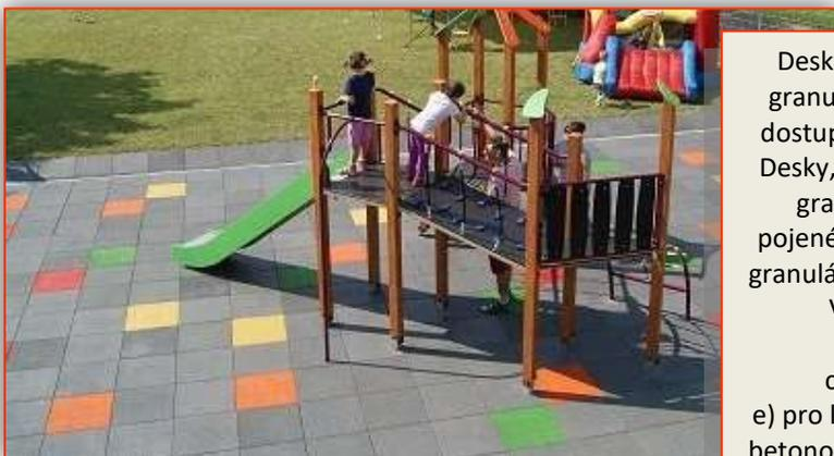
Desky, puzzle a obrubníky jsou vyráběny z černého pryžového granulátu pojeného barevným polyuretanovým lepidlem a jsou dostupné ve 4 základních barvách - černá, červená, zelená, šedá. Desky, puzzle a obrubníky s EPDM (horní vrstva je tvořena EPDM granulátem) jsou vyráběny z černého pryžového granulátu pojeného polyuretanovým lepidlem a horní vrstvy tvořené EPDM granulátem, který je dostupný v různých barvách dle stupnice RAL. Výrobky jsou vyráběny v několika verzích pro použití:
